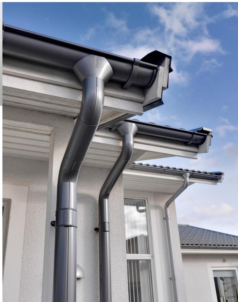
Стальные листы, из которых изготавливается водосточная система, - это прочный, гибкий и долговечный материал. Яркое грязеотталкивающее покрытие HVP сохраняет глубокий цвет и обладает стойкостью к истиранию. Все элементы собираются по принципу конструктора: собери и защелкни без клея и силикона.
